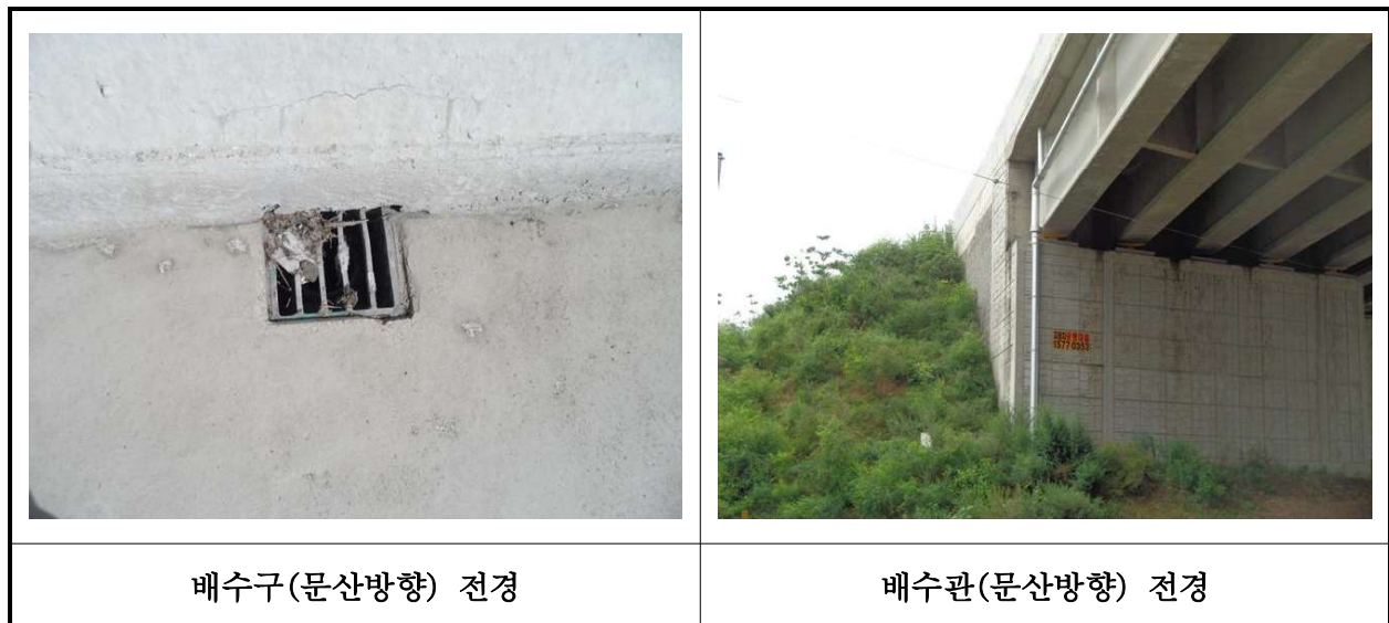
【사진 38.3.40】 배수시설(문산방향) 전경
