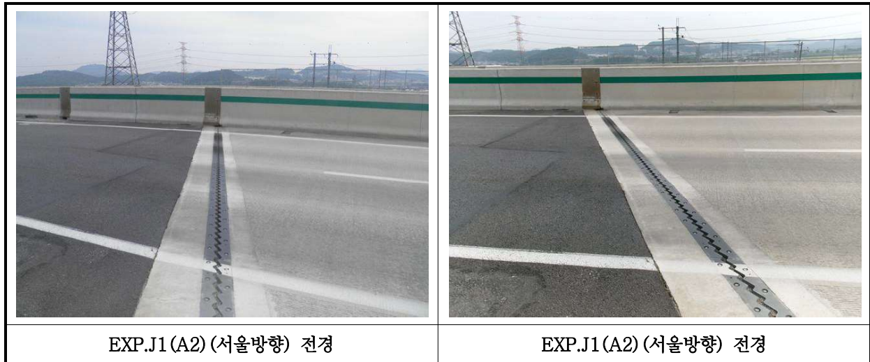
【사진 38.3.14】 신축이음장치 전경
