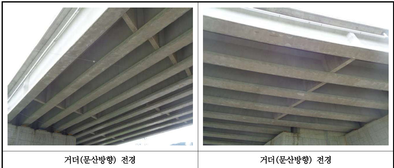
【사진 38.3.25】 거더(문산방향) 전경
