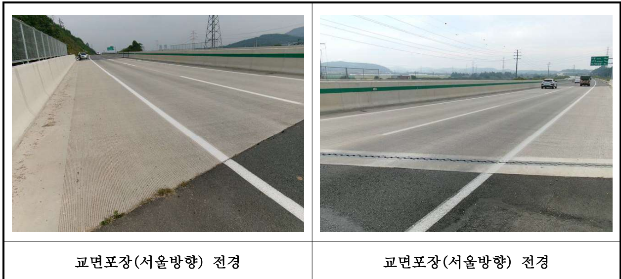
【사진 38.3.17】 교면포장(서울방향) 전경
