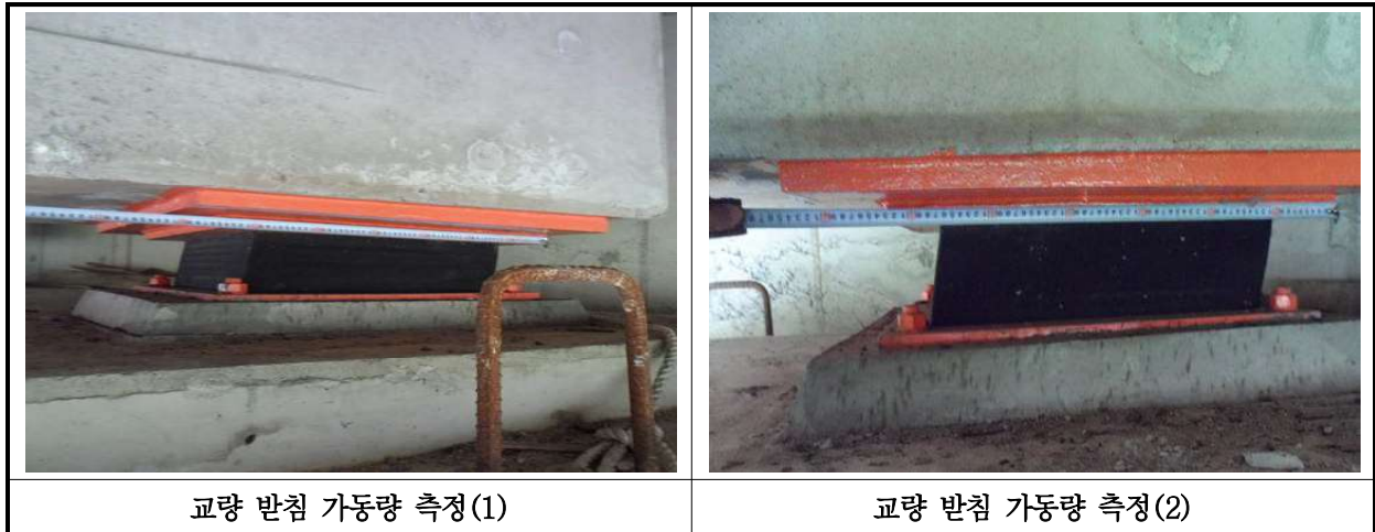
【사진 38.3.34】 교량받침(문산방향) 이동량 측정
