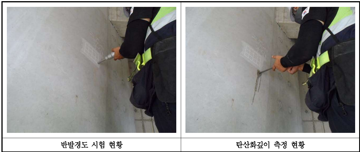
【사진 38.4.1】 콘크리트 내구성조사 현황
