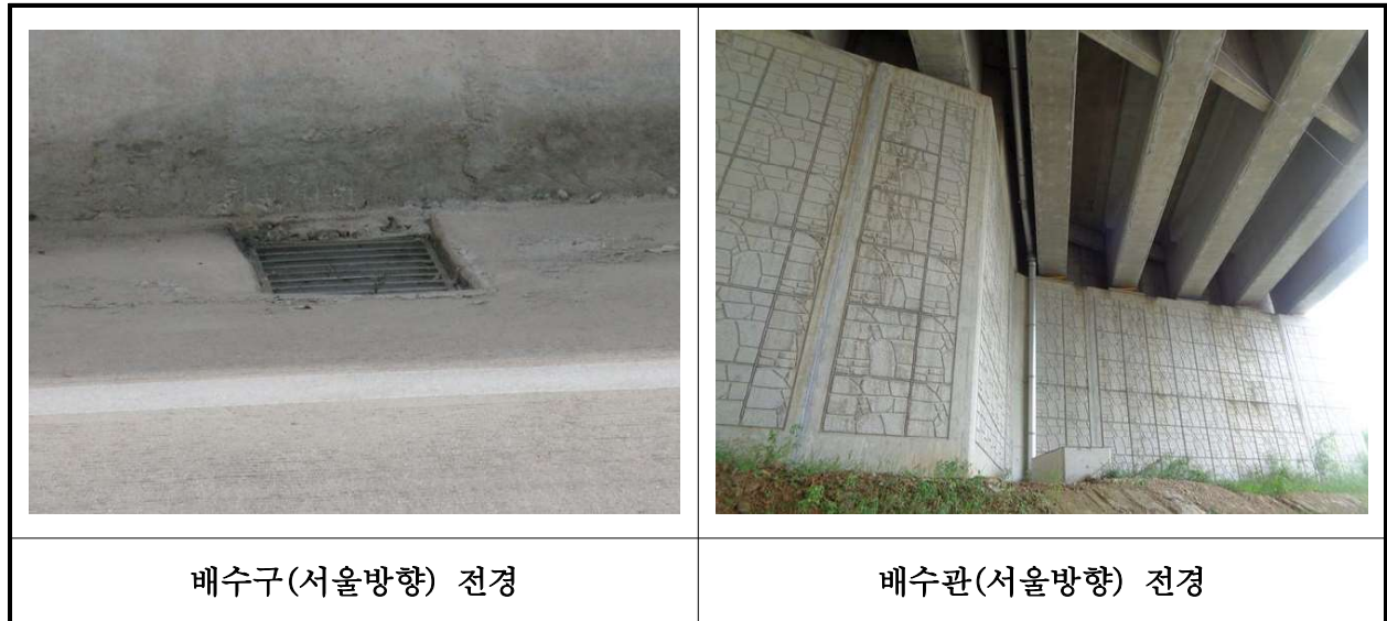
【사진 38.3.19】 배수시설(서울방향) 전경
