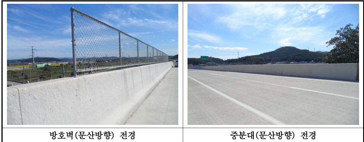
【사진 38.3.42】 방호벽 및 중앙분리대(문산방향) 전경
