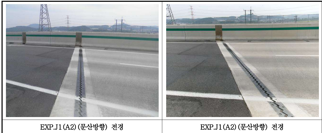
【사진 38.3.35】 신축이음장치(문산방향) 전경
