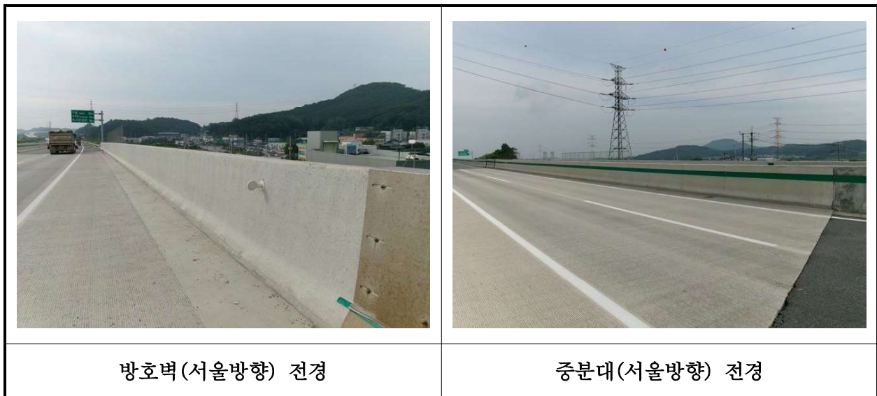
【사진 38.3.21】 방호벽 및 중앙분리대(서울방향) 전경
