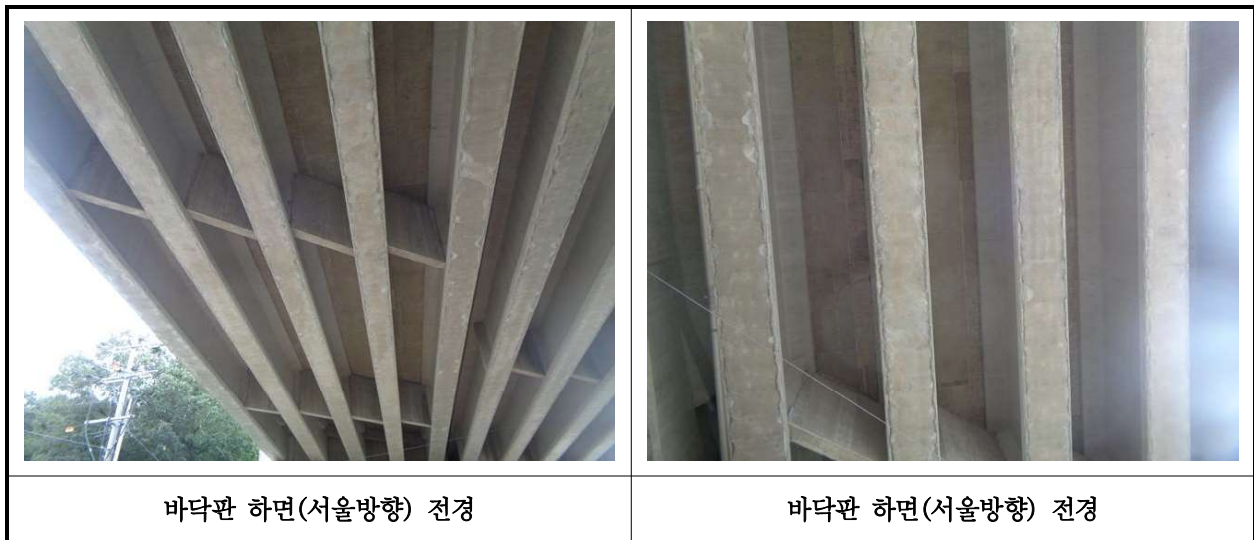
【사진 38.3.2】 바닥판하면(서울방향) 전경
