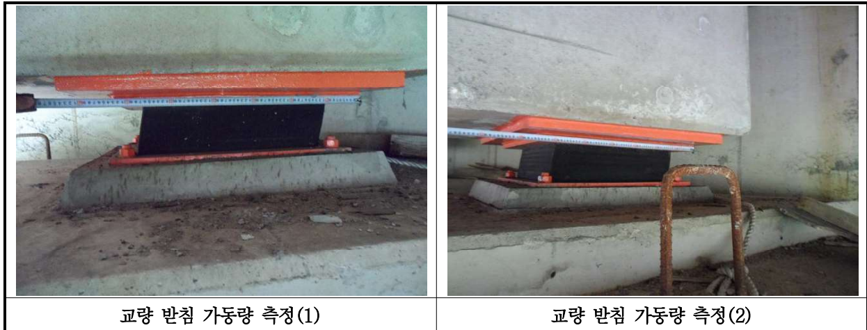
【사진 38.3.13】 교량받침(서울방향) 이동량 측정
