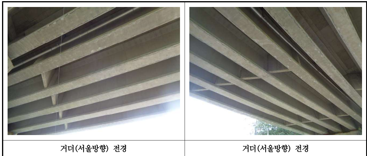
【사진 38.3.4】 거더(서울방향) 전경
