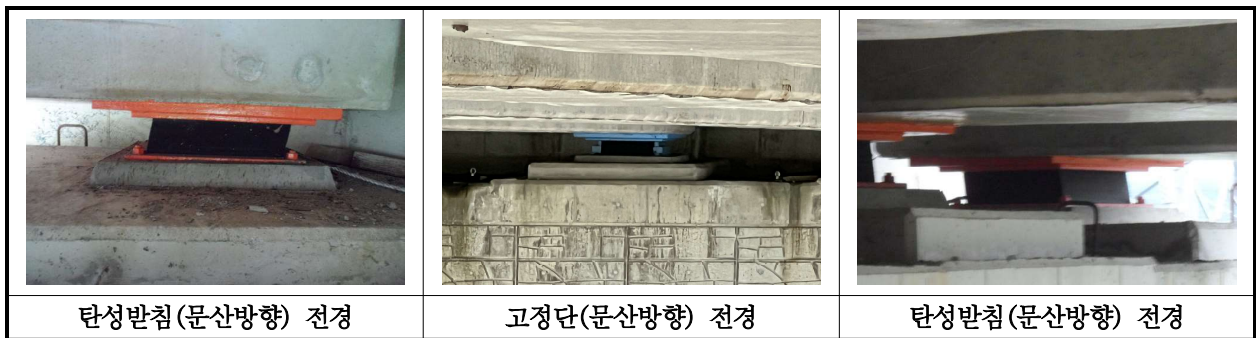
【사진 38.3.31】 교량받침(문산방향) 전경
