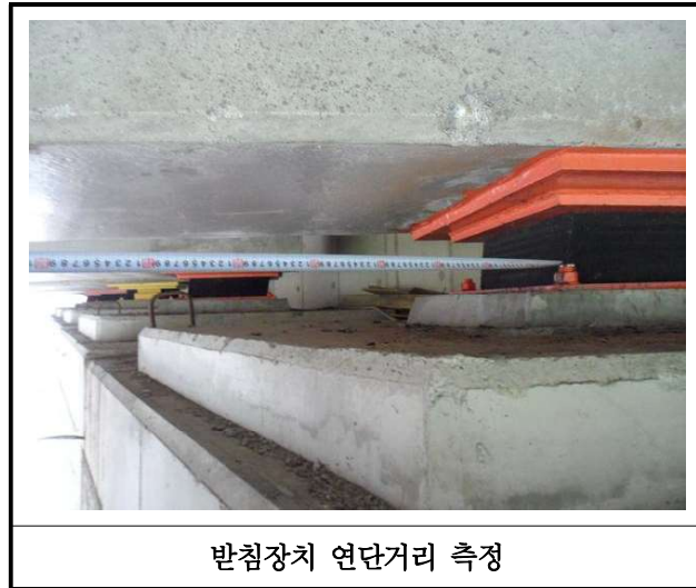
【사진 38.3.12】 교량받침장치 연단거리측정
