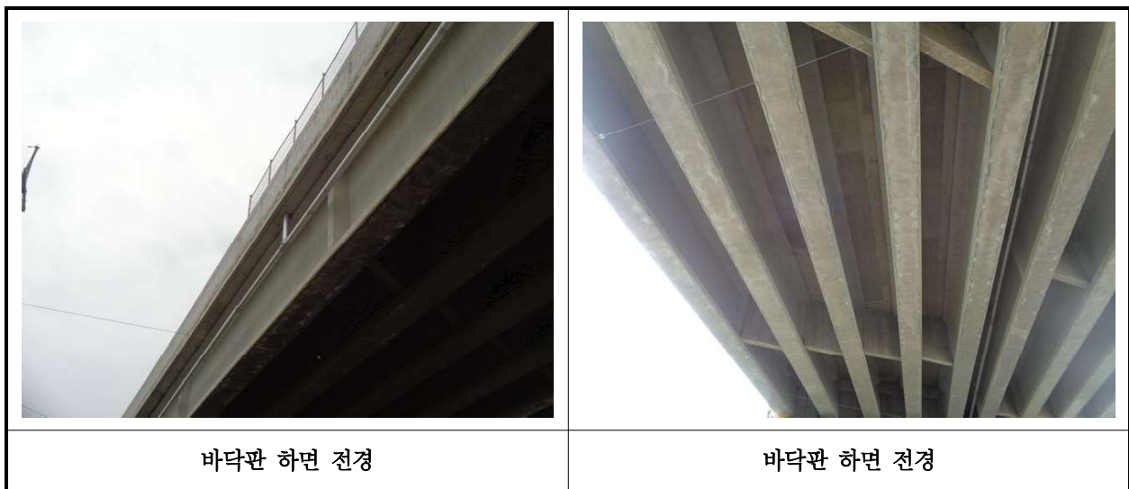
【사진 38.3.23】 바닥판하면(문산방향) 전경
