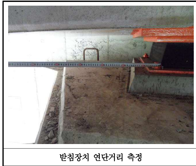
【사진 38.3.33】 교량받침장치 연단거리측정
